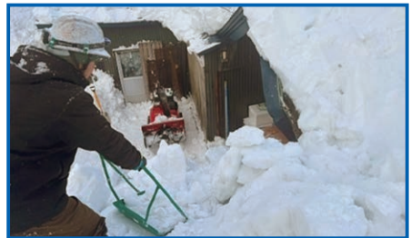
災害救助法による屋根雪下ろし
